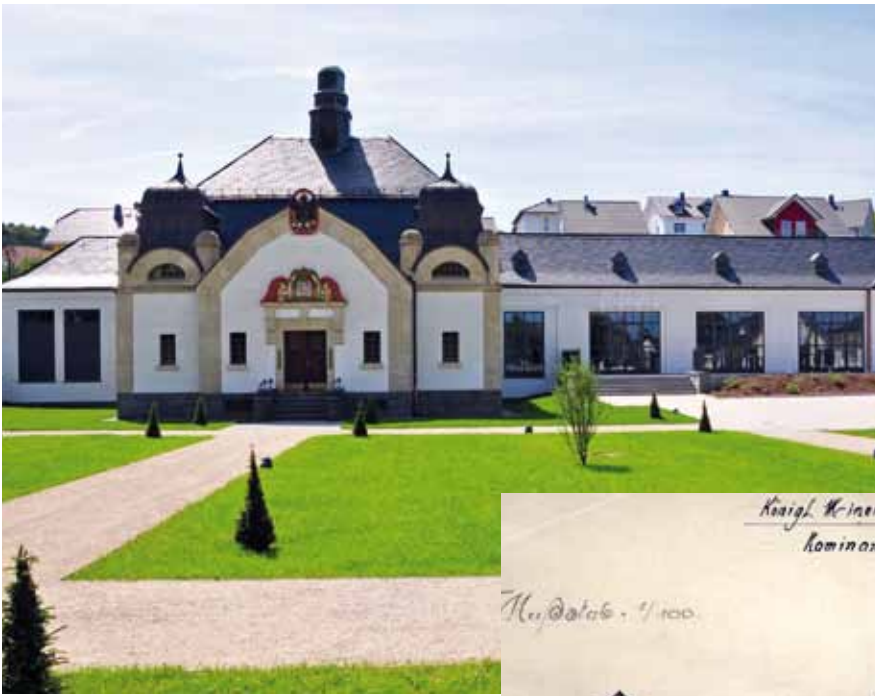
Der Brunnentempel wurde originalgetreu restauriert, 2011 (Foto: Geschichtsverein Goldener Grund)
